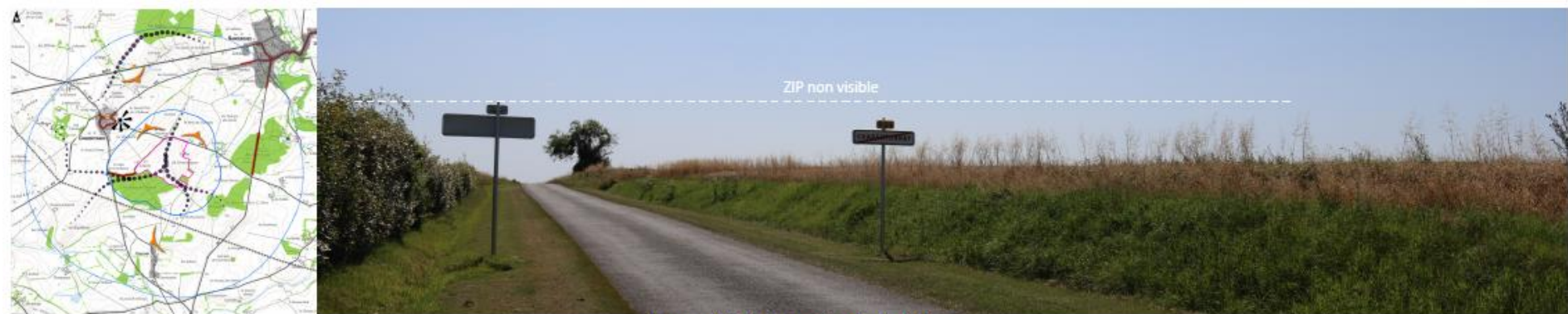
Photographie 27. Vue en direction de la ZIP
