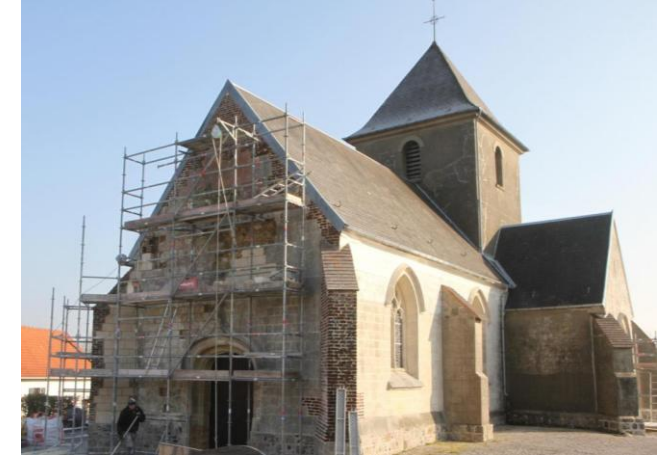
Rénovation de bâtiments
