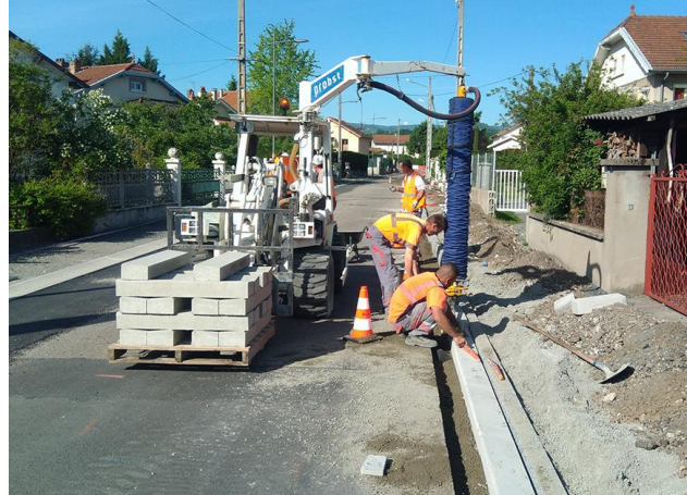
Travaux de voirie
